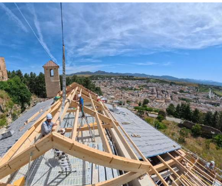
INSTALACIONES DE IBEROLAM
