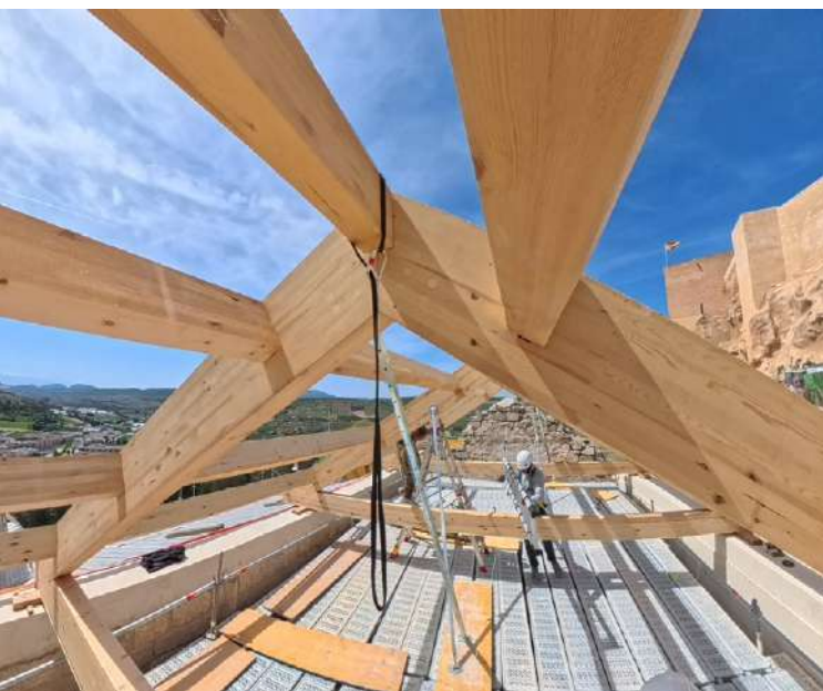
INSTALACIONES DE IBEROLAM
