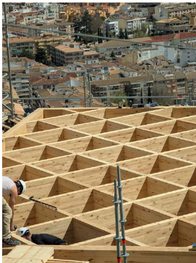
INTERVENCIÓN EN PATRIMONIO / IBEROLAM
