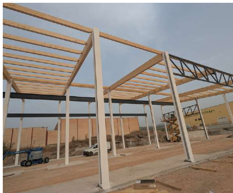
INTERVENCIÓN EN PATRIMONIO / IBEROLAM
