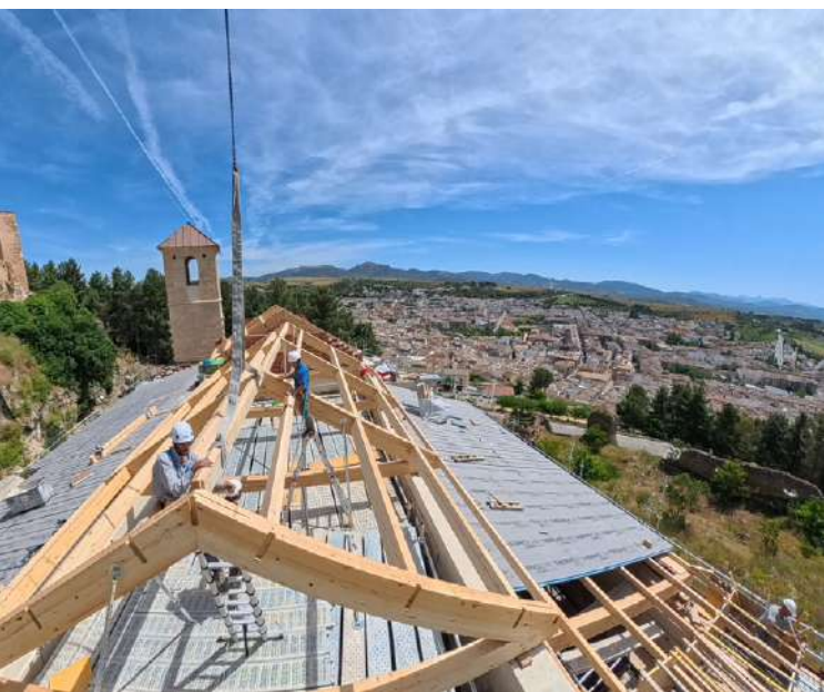
INSTALACIONES DE IBEROLAM
