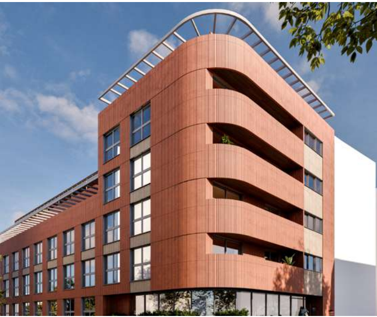
COHOUSING EN MADERA CLT PARA EMVS OFELIA NIETO / CANO Y ESCARIO ARQUITECTURA
