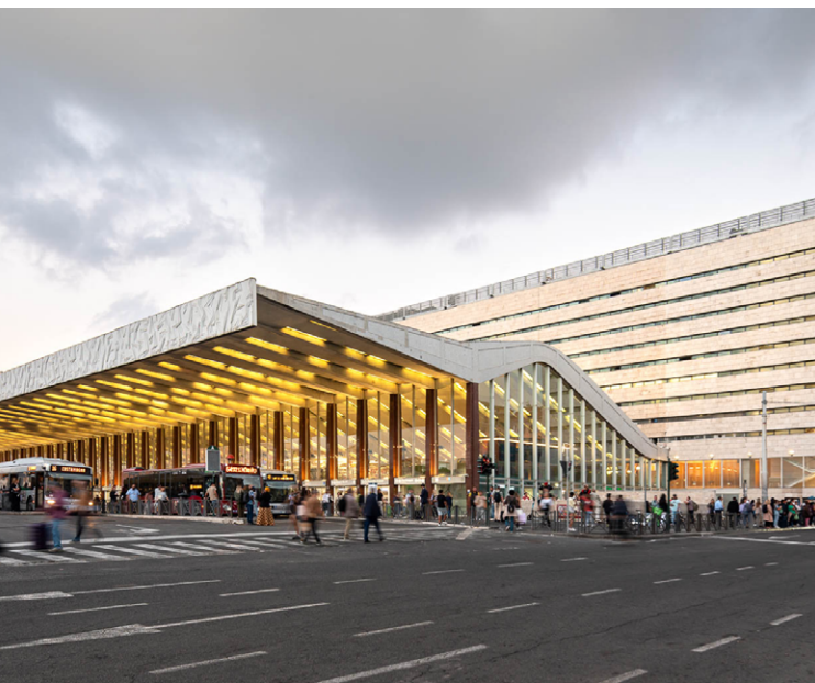
REHABILITACIÓN ESTACIÓN ROMA TERMINI / L35 ARCHITECTS
