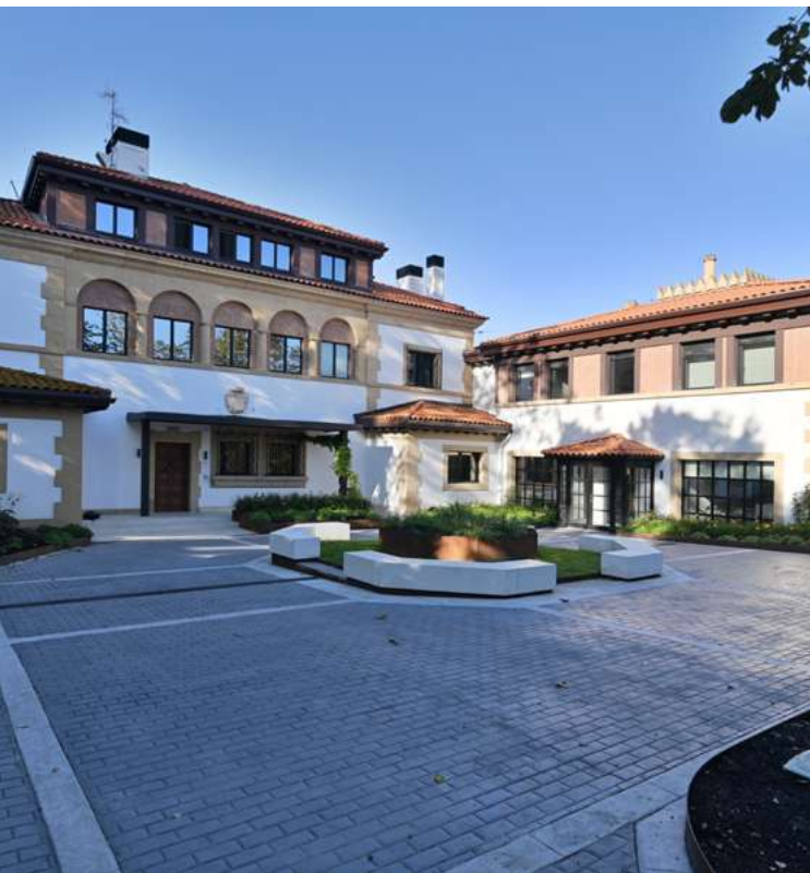
REHABILITACIÓN ATXEKOLANDETA / ARQUIPLAN 2.0
