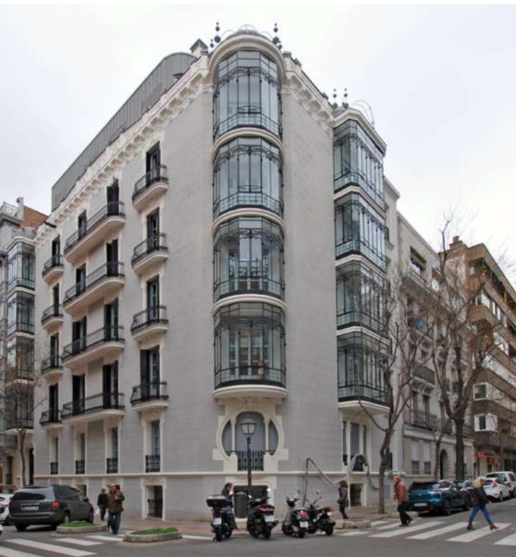
REHABILITACIÓN EDIFICIO AYALA 63, MADRID / E.BAJARDÍ & ASOCIADOS
