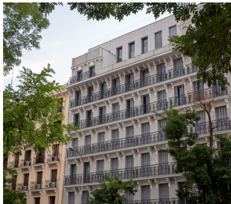
FACHADA SAN BERNARDO, 126 / REHABILITA
