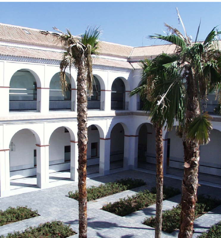
PARLAMENTO DE ANDALUCÍA (REHABILITACIÓN DEL HOSPITAL DE LAS CINCO LLAGAS, SEVILLA) / AROCA ARQUITECTOS
