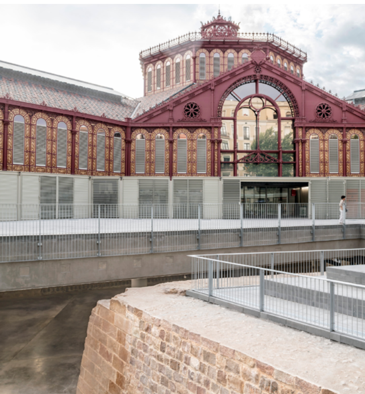
MERCADO DE SANT ANTONI / RAVETLLAT ARQUITECTURA
