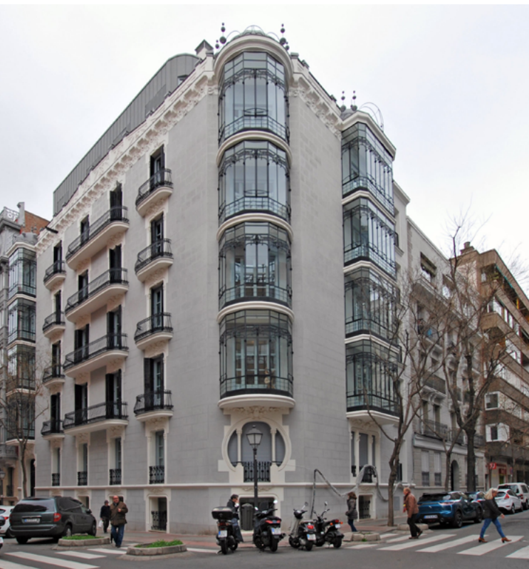
REHABILITACIÓN EDIFICIO AYALA 63, MADRID / E.BAJARDÍ & ASOCIADOS
