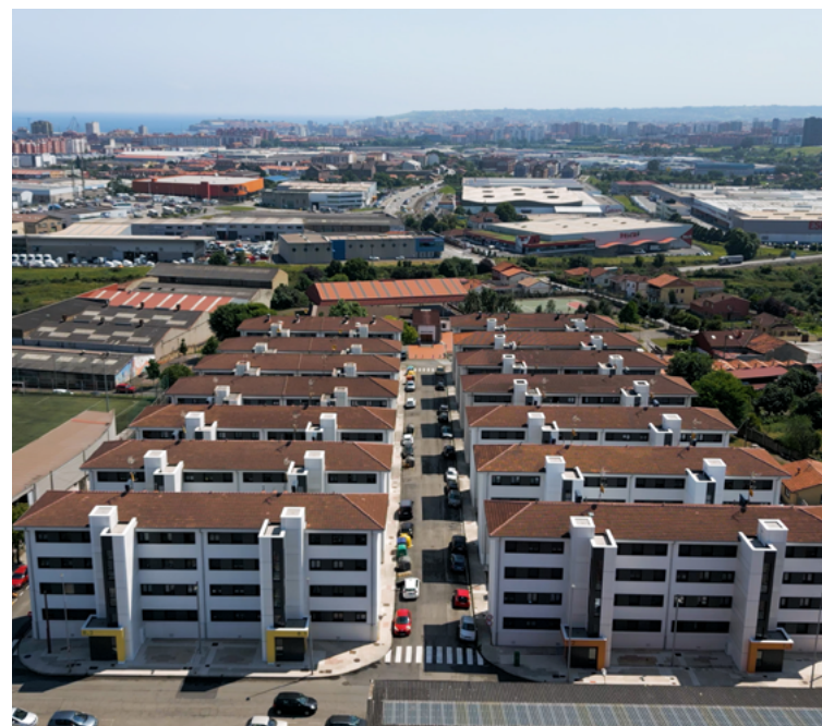
REHABILITACIÓN ENERGÉTICA DE GRUPOS DE VIVIENDAS EN MANZANAS DEGRADADAS TREMAÑES, GIJÓN. / ESFER
