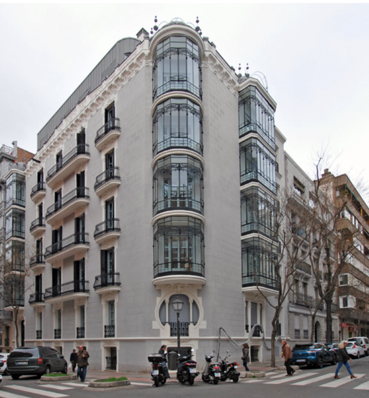
REHABILITACIÓN EDIFICIO AYALA 63, MADRID / E.BAJARDÍ & ASOCIADOS
