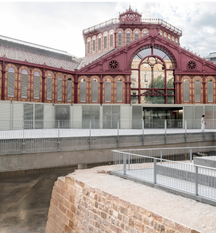
MERCADO DE SANT ANTONI / RAVETLLAT ARQUITECTURA
