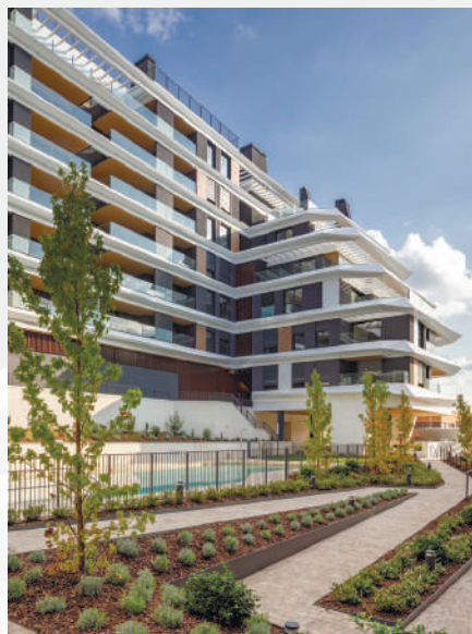
Ibossa Stellae / Cano y Escario Arquitectos
