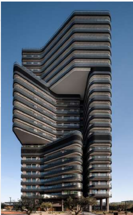
Torre Australis / Martín de Lucio Arquitectos
