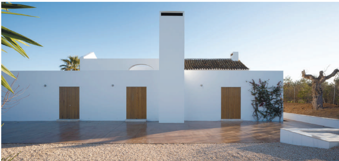
Foto: Rehabilitación de vivienda rural en Arahál Sevilla / Daroca Arquitectos
