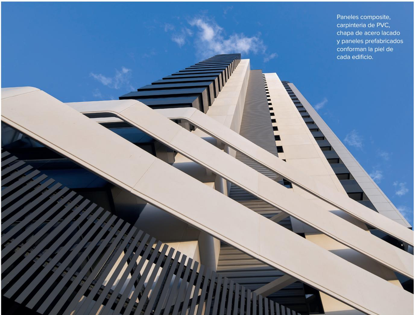
Paneles composite, carpintería de PVC, chapa de acero lacado y paneles prefabricados conforman la piel de cada edificio.
