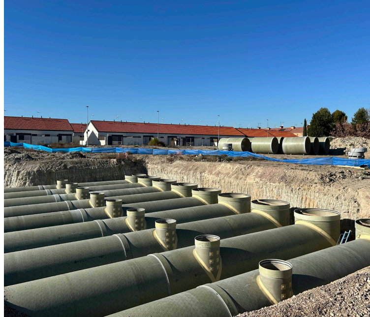
Foto: Tanque de tormentas PRFV de Amiblu en Ciempozuelos (Madrid)
