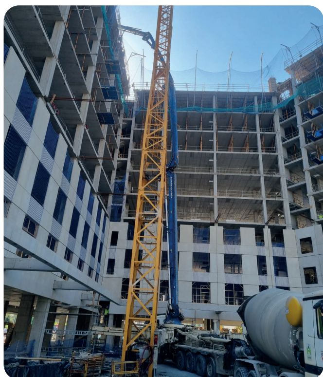
Edificio Node Barakaldo en construcción
