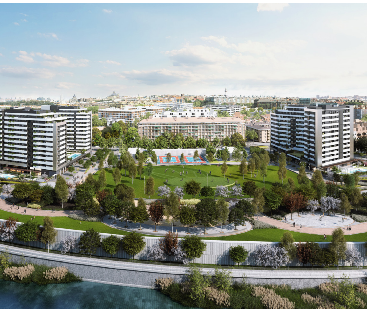
RESIDENCIAL MAHOU CALDERON / TOUZA ARQUITECTOS
