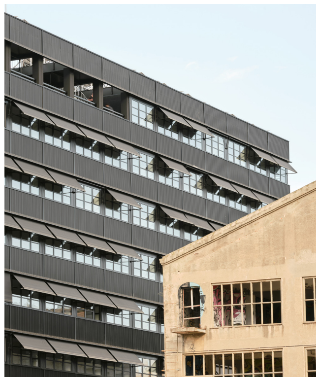
45 VIVIENDAS SOCIALES INDUSTRIALIZADAS EN LA CALLE DEL MARROC, BARCELONA / VIVAS ARQUITECTOS
