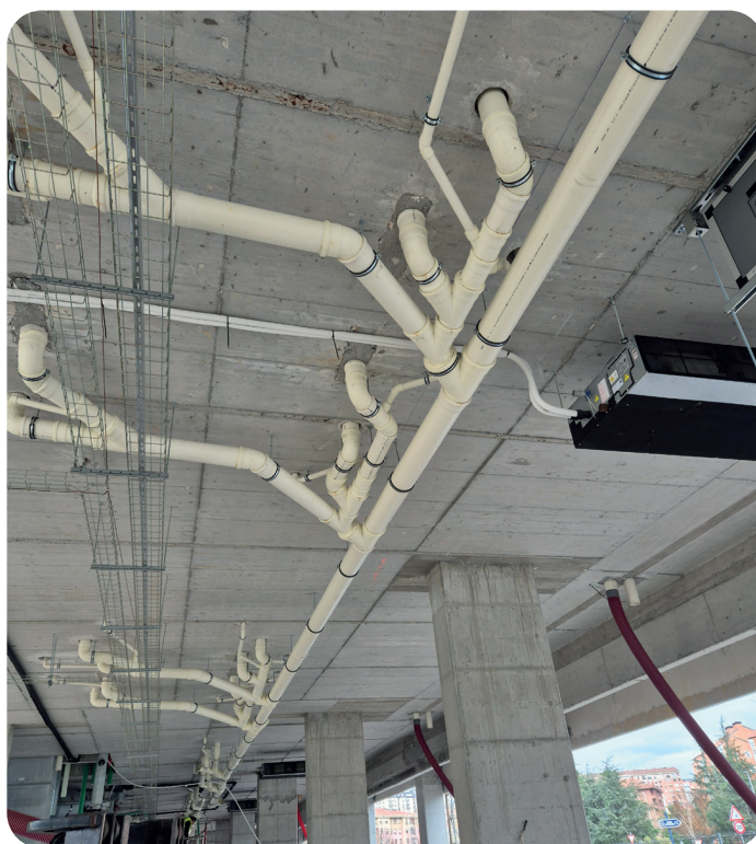
Instalación del Sistema de evacuación insonorizado AR® en el Node Barakaldo
