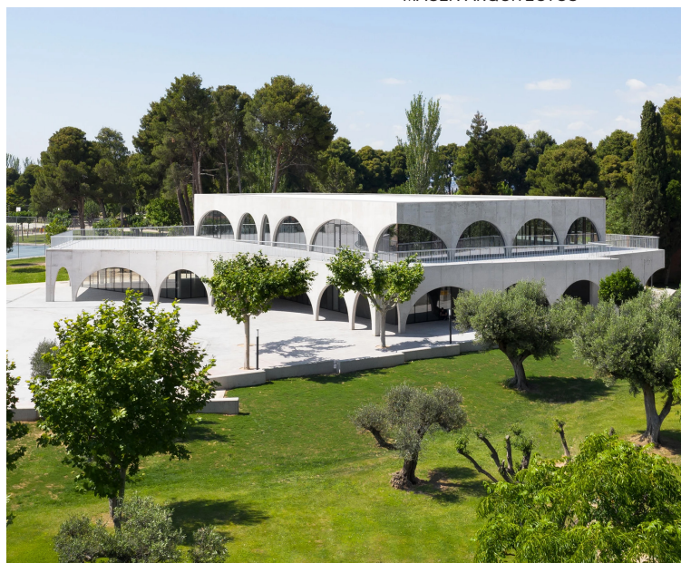
PABELLÓN SOCIAL MIRALBUENO-EL OLIVAR EN ZARAGOZA / MAGÉN ARQUITECTOS
